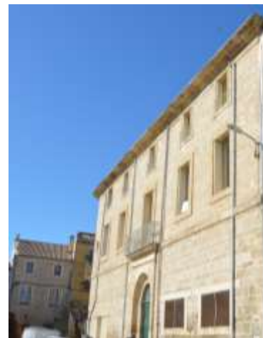
Exemple de grande demeure de faubourg pouvant inclure plusieurs logements
