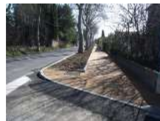
Nouvel aménagement piéton avenue de la Gare
